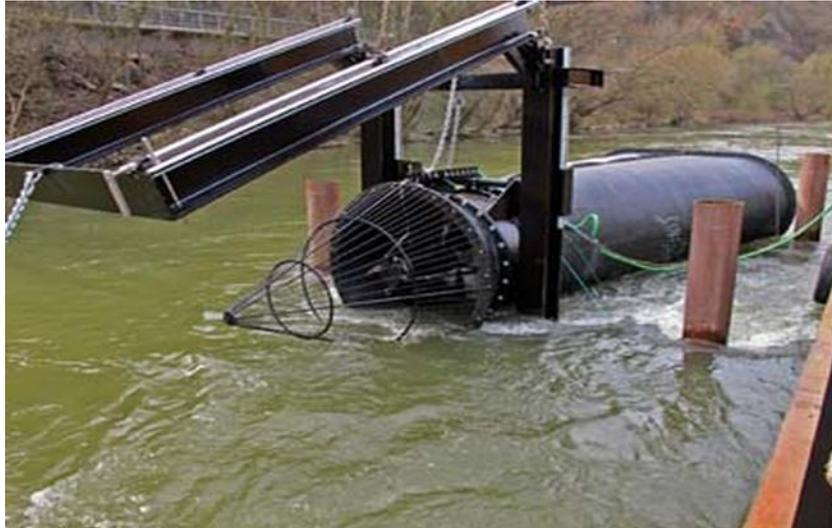
Abbildung 27: Installation einer KSB-Flussturbine bei St. Goar<sup>131</sup>
