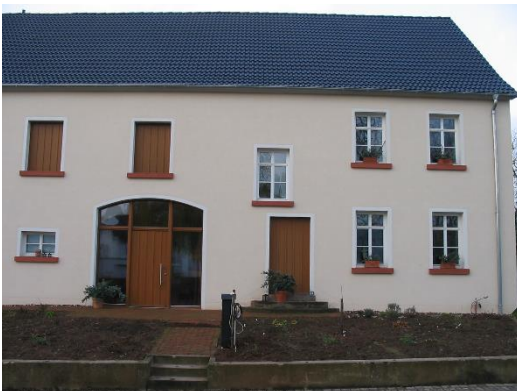
Das gleiche Gebäude – jetzt ein Niedrigenergiehaus Fotos: VZ RLP/ Bernhard Andre
