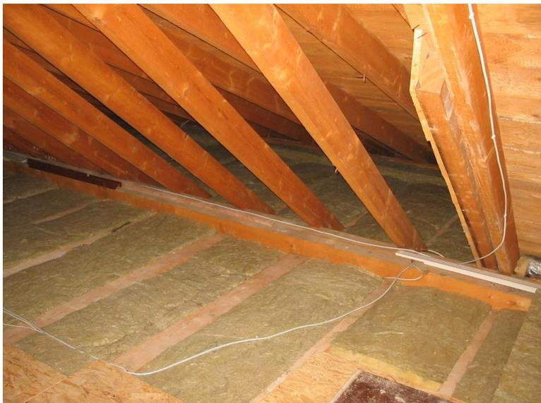
**Bildunterschrift für anhängendes Foto:** Holzbalkendecken lassen sich von oben optimal mit Mineralwolle zwischen den Deckenbalken dämmen. Durch die Abdeckung mit OSB-Platten wird der Dachraum wieder begehbar.
