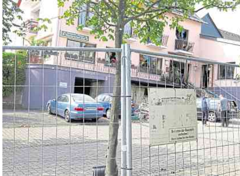
Zutritt verboten: Mit einem Bauzaun wurde die Gaststätte „Masterscher Hof“ nach der Gasexplosion weiträumig abgesperrt. Foto: Volker Boch
