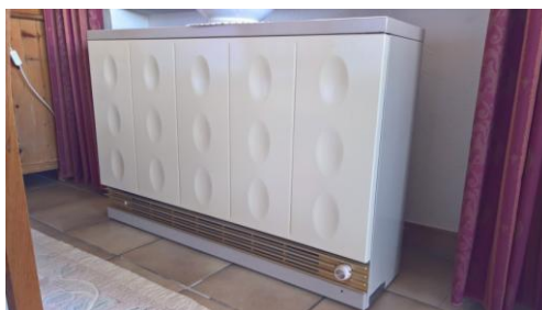
Nachtspeicherheizung Foto: Bernhard André
