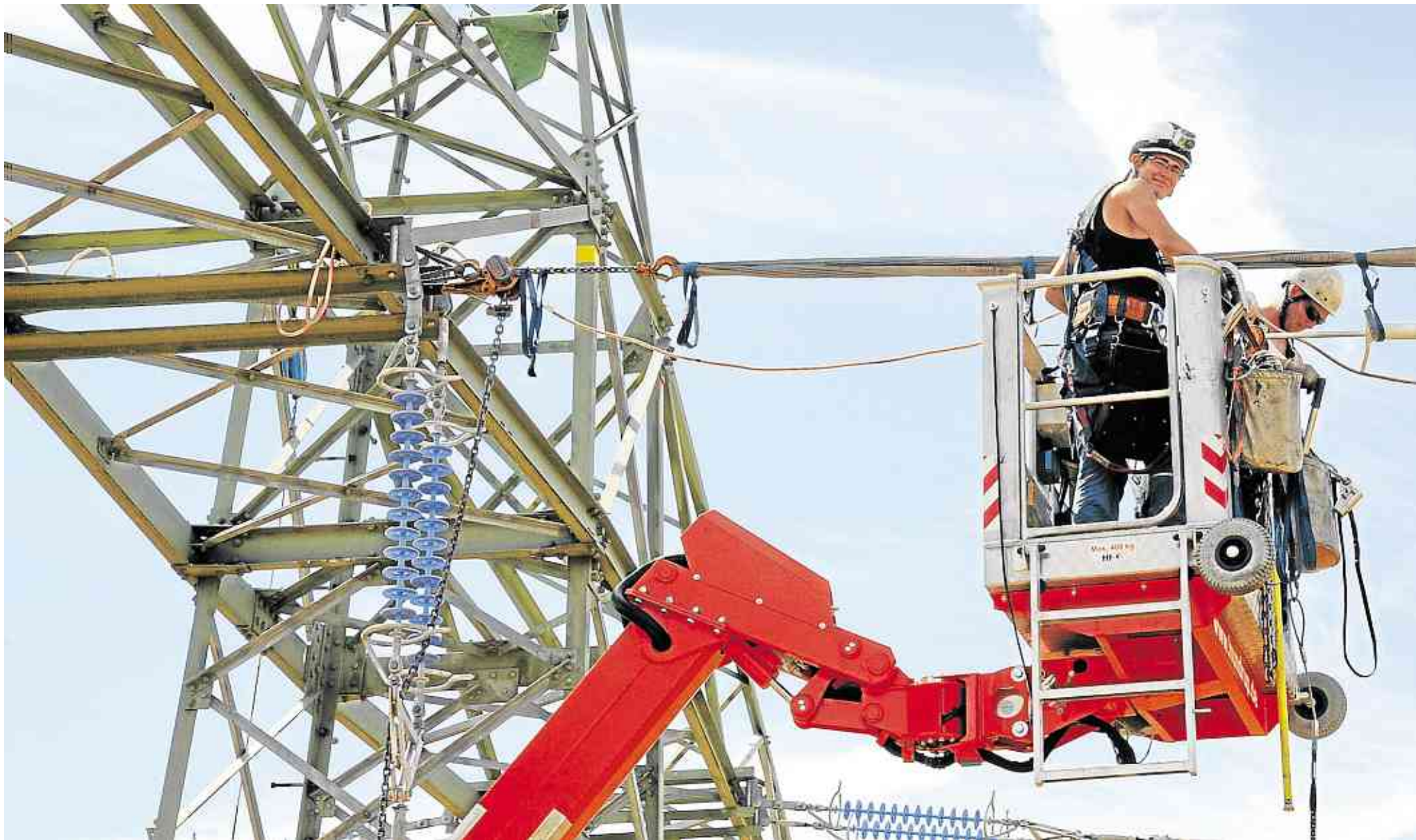
Netzertüchtigung statt Neubau. Zwischen Simmern und Rheinböllen wurde im Sommer ein neuartiges Leiterseil an die bestehende Stromtrasse installiert. Damit hat sich die Kapazität für Windstrom im Netz schlagartig erhöht. Durch den Einsatz der neuen Technik kann ein konventioneller Netzausbau vermieden werden.
