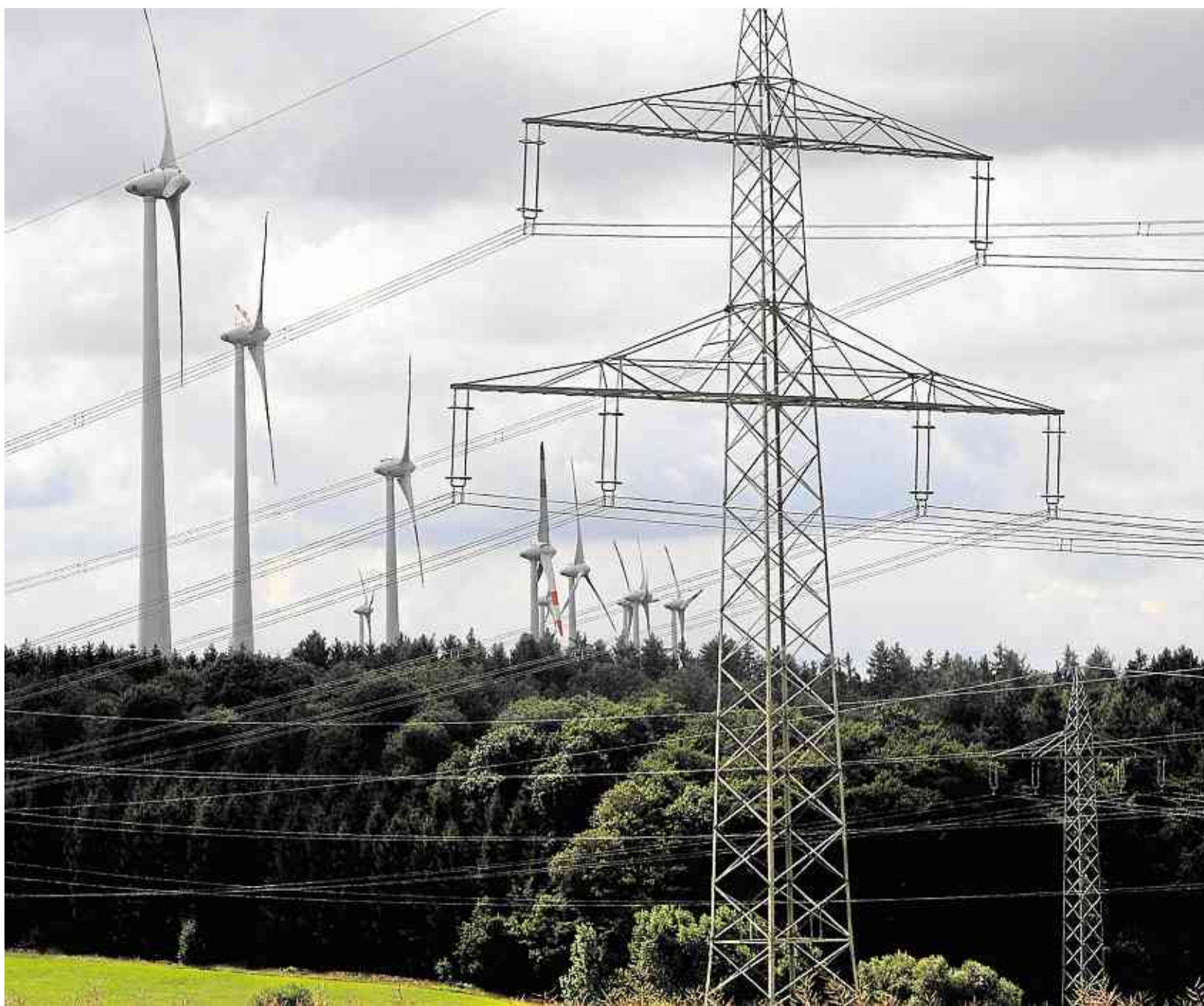
Wie hier bei Kisselbach treffen entlang der Autobahn Windenergieanlagen auf das Übertragungsnetz der Höchstspannungsstrasse Amprion und das Verteilnetz der 110-Kilovolt-Hochspannungsleitung. Unser Stromnetz kann die erzeugte Windenergie problemlos aufnehmen.
