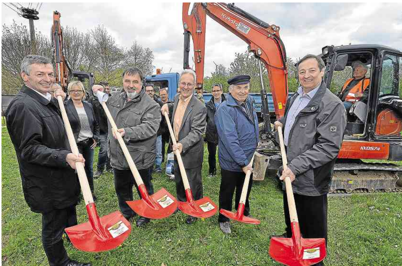
Startschuss für den Nahwärmeverbund Neuerkirch-Külz: VG-Bürgermeister Michael Boos (von links), Bürgermeister Volker Wichter (Neuerkirch), Planer Ulrich Schäfer, Bürgermeister Aloys Schneider (Külz) und ERS-Chef Gerhard Wust beim Spatenstich für das Millionenprojekt.
