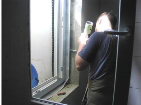
Montageschaum reicht beim Einbau neuer Fenster nicht aus – der Rahmen muss luftdicht in der Leibung verklebt werden. **Foto: VZ RLP**
