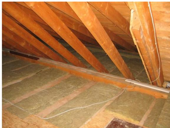
Holzbalkendecken lassen sich von oben optimal mit Mineralwolle zwischen den Deckenbalken dämmen. Durch die Abdeckung mit OSB-Platten wird der Dachraum wieder begehbar.
